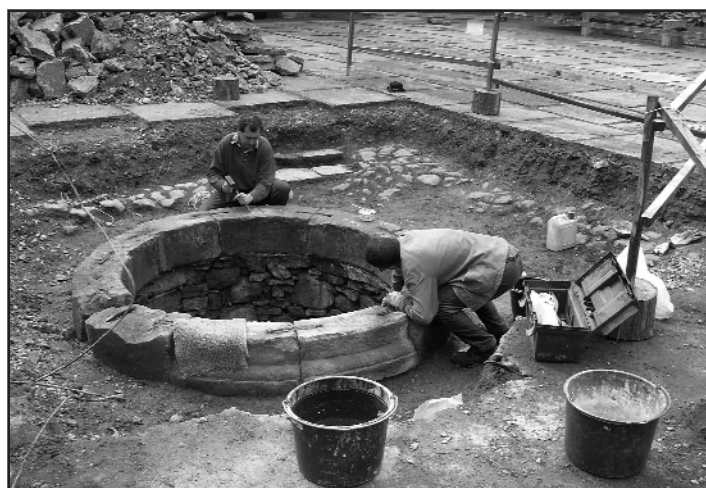
Reštaurovanie kamennej rímky studne
